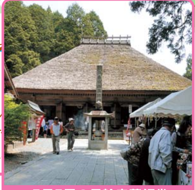
5月5日の月輪寺薬師堂 [国指定重要文化財]
